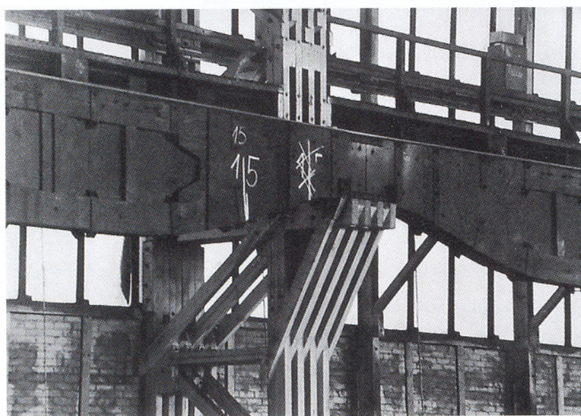
Bild 13. Kranbahnträger einer Lokhalle, geleimte Träger mit Gurten aus Brettschichtholz und Stegen aus fünfplagigem Sperrholz, Ausführung Fa. Christoph & Unmak 1938 Fig. 13. Crane girder of railway hall
